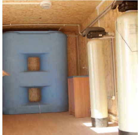
Рис. 2.3.8 Смонтированное внутри контейнера водоочистное оборудование
