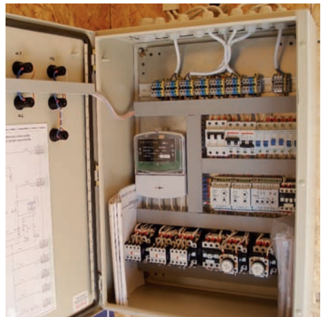
Рис. 2.3.9 Шкаф управления и защита смонтированное в контейнере электрооборудования
