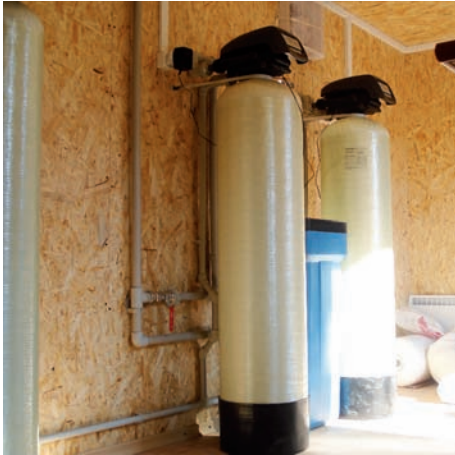
Рис. 2.3.8 Смонтированное внутри контейнера водоочистное оборудование
