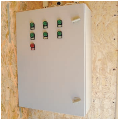
Рис. 2.3.9 Шкаф управления и защита смонтированное в контейнере электрооборудования
